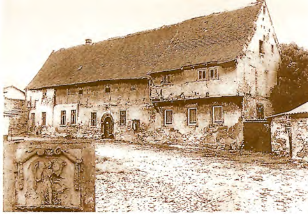
Panitzsch: Blauer Engel, Lange Straße, um 1600, Abriss 1994
